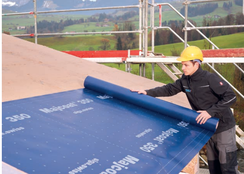
SIGA Majcoat 350 ist diffusionsoffen und gleichzeitig schlagregendicht. Sie ist dreilagig aufgebaut und verfügt über ein robustes Trägervlies.
