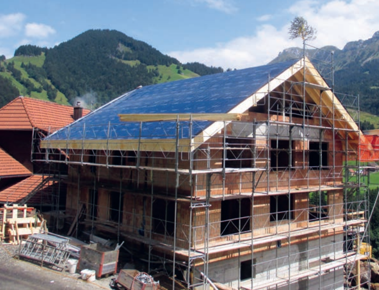
SIGA Majcoat 350 für Dachkonstruktionen mit ausserordentlicher Beanspruchung für erhöhte Gebiete (gemäss SIA 232/1).
