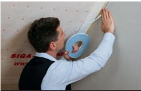
Połączenie paroizolacji i ściany masywnej
