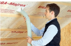
Montaż paroizolacji przy ociepleniu wykonywanym metodą wdmuchiwania
