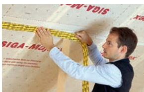
Połączenie zakładów paroizolacji
