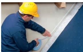
Połączenie membrany dachowej i ściany asywniej
