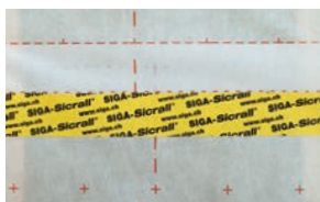
Połączenie zakładów paroizolacji
