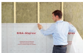
Montaż paroizolacji
