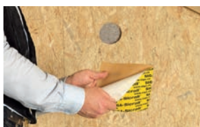
Otwór do wykonywania ociepleń metodą wdmuchiwania
