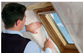
Collegamento finestre per tetti
