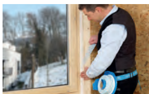
Finestra su parete massiccia
