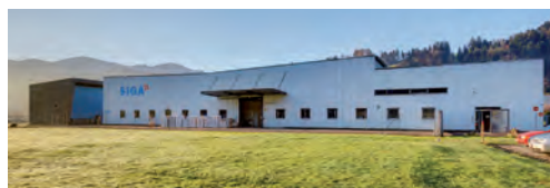
Stabilimento di Schachen
