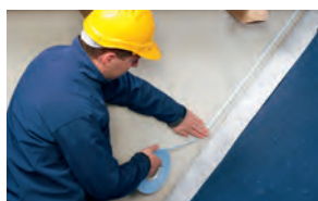
Telo sotto copertura su parete massiccia
