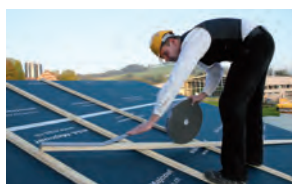
Applicazione nastro resistente ai chiodi
