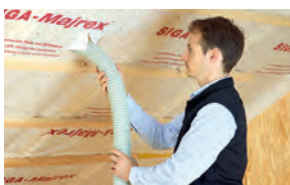
Applicazione barriera al vapore con isolamento insufflato
