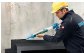
Sigillare perdite, crepe, fessure e passaggi
