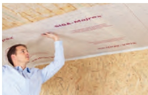
Applicazione barriera al vapore
