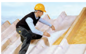
Applicazione barriera al vapore per risanamento esterno del tetto
