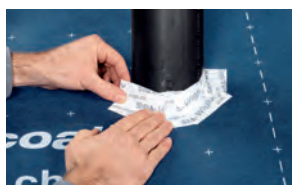
Teli sotto copertura - fessure
