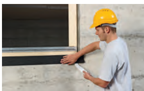
Finestra su parete massiccia
