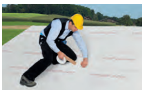
Applicazione barriera al vapore per l'isolamento
