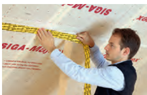
Sovrapposizione teli per barriere al vapore
