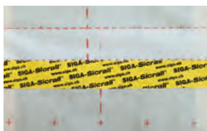
Sovrapposizione teli per barriere al vapore
