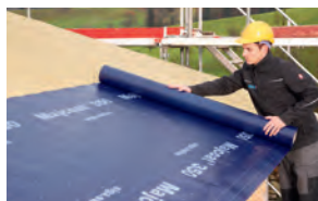
Applicazione telo sotto copertura
