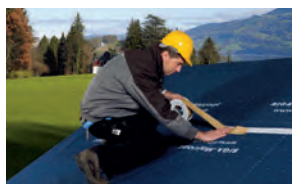
Teli sotto copertura - sovrapposizioni
