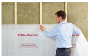
Applicazione barriera al vapore su struttura in legno
