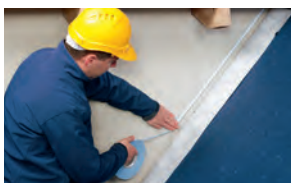
Telo sotto copertura su muri massicci
