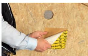
Fori di insufflazione
