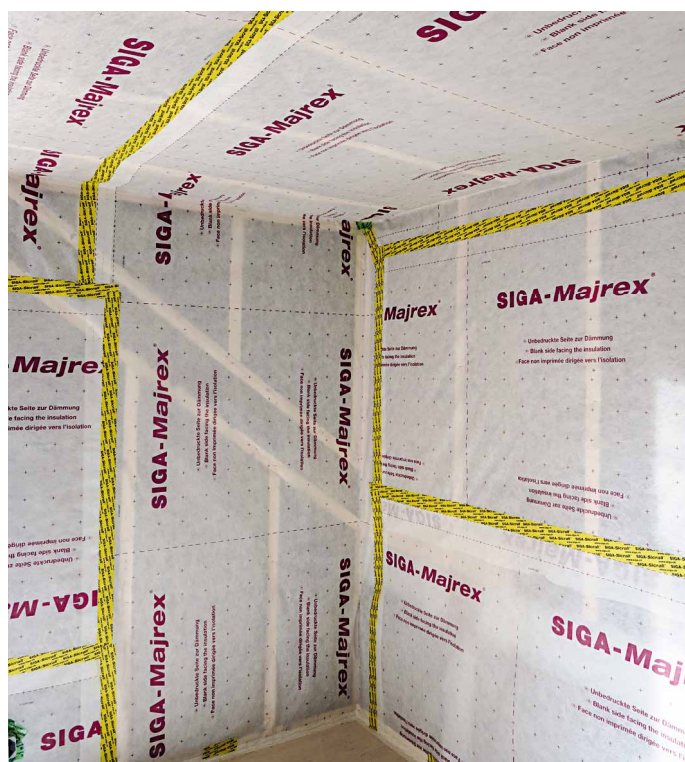
Abb. 4: Die luftdichte Ebene des Gaubendaches und die Gaubenwangen wurde mit der neuen SIGA-Majrex ausgeführt.
