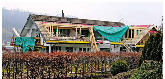
Abb. 2: Gebäude in der Bauphase mit neu erstellter Dachgaube. Das Gaubendach sollte begrünt werden.
