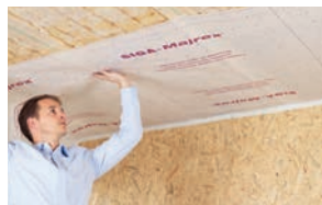
Montering av ångspärr
