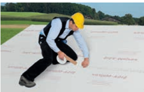
Montering av ångspärr vid påläktsisolering
