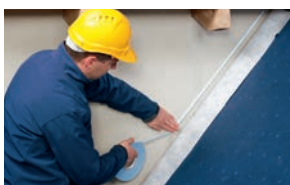
Anslutning av takmembran mot massiv vägg
