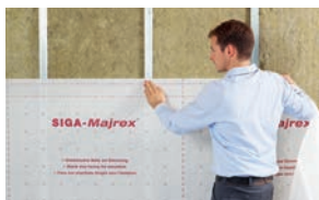
Montering av ångspärr
