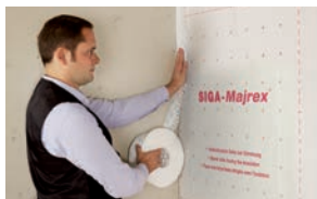
Ansluta ångbroms eller ångspärr mot massiv vägg
