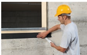
Tätning av fönster i massiv vägg
