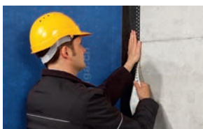
Anslutning av fasad- membran mot massiv vägg
