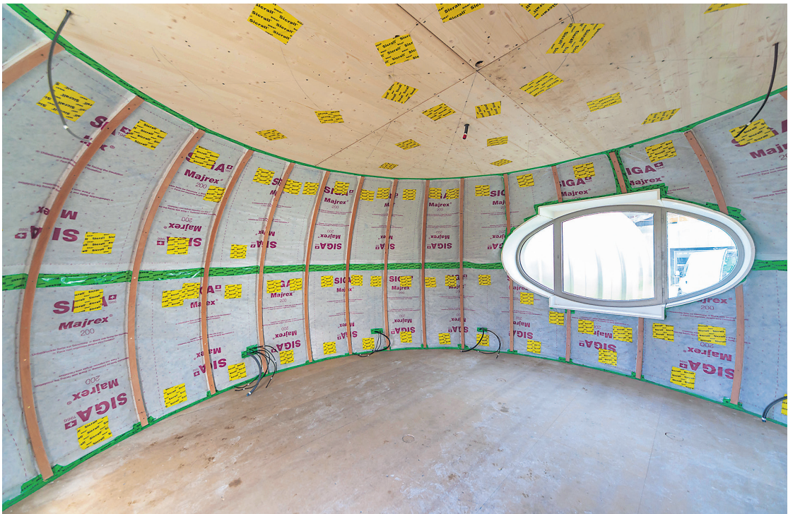
Von SIGA abgedichtet: Eines von 42 energiesparenden Hotelzimmern beim Château des Pères bei Rennes.
