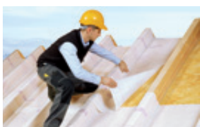
Tvaika izolācijas montāža, renovējot jumtu no ārpuses
