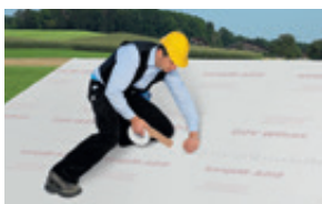
Tvaika izolācijas slāņa montāža savietotā kons- trukcijā, kad siltumizolācija tiek montēta virs spārēm
