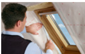
Jumta loga rāmja savienojums ar tvaika izolāciju
