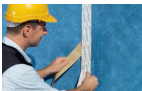
透汽膜铺装搭接
