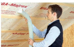
注入式保温层的隔汽膜铺装
