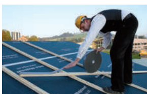
挂瓦条背部使用 Nail sealing tape II 胶带
