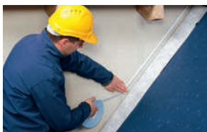
屋顶处透汽膜与实体墙体粘接
