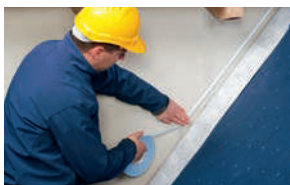
屋顶处透汽膜与实体墙体粘接
