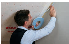
隔汽膜与实体墙体粘接
