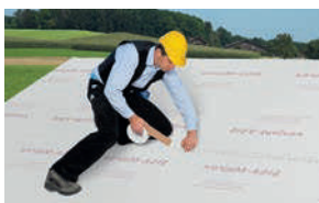
在望板上铺装隔汽膜
