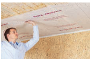
在平斜屋顶铺装隔汽膜
