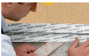
室外底部接缝
