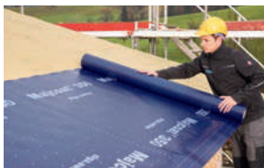
屋顶铺装透汽膜
