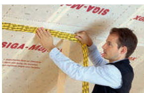
隔汽膜铺装搭接
