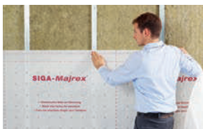
在内保温结构墙面铺装隔汽膜
