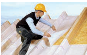
在对屋面进行外部翻新时铺设隔汽膜
