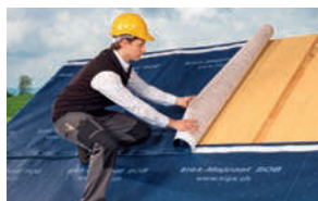
进行外部翻新时铺装透汽膜
