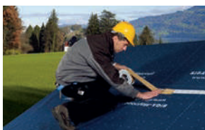
屋顶透汽膜铺装搭接
