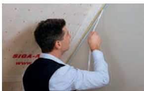
隔汽膜与实体墙体粘接
