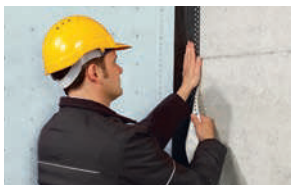
透汽膜与实体墙体粘接
