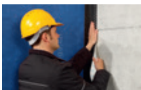
Fasadinės membranos jungtis su mūrinės konstrukcijos siena
