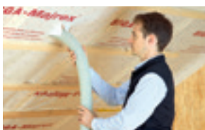
Garų izoliacinio sluoksnio įrengimas, kai šiltinama įpurškiamąja šilumine izoliacija
