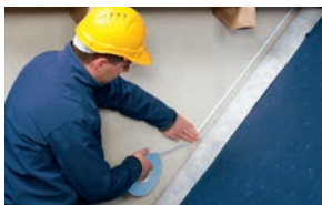
Underlagsduk mot betong-/murvegg
