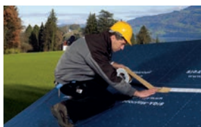
Overlapping av underlagsduker
