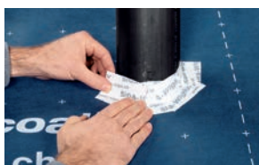
Gjennomføring i underlagsduker
