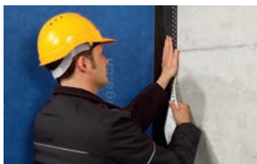
Vindsperre mot betong-/ murvegg
