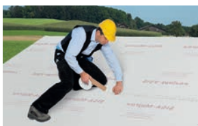
Montering av dampbrems ved isolasjon over sperrer
