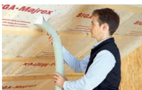
Montering av dampbrems ved blåseisolasjon
