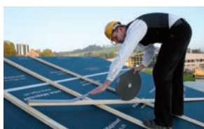
Montering av spikertett-tape
