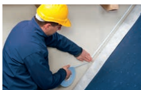
Underlagsduk mot betong-/murvegg
