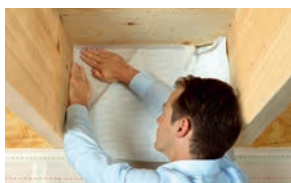
Lufttetting mellom bjelkelag
