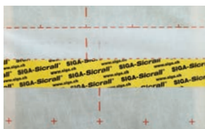
Overlapper av dampbrems
