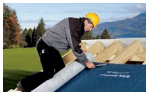
Montering av underlagsduk
