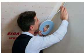
Dampbrems mot betong-/murvegg
