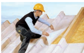
Montering av dampbrems ved takrehabilitering utenfra
