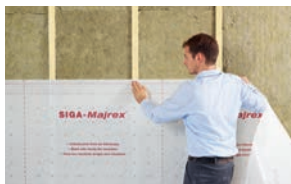
Montering av dampbrems
