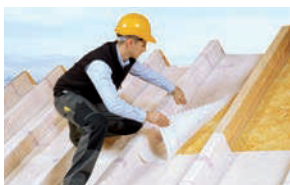
Höyrysulkukerroksen kiinnittäminen katon kunnostusta varten ulkopuolelta
