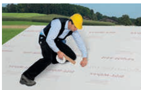
Höyrysulkukerroksen kiinnittäminen yläpaar- teiden päällä olevaan eristeseen
