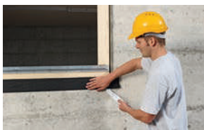
Ikkunan yhdistäminen massiiviseinärakenteeseen
