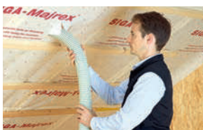
Höyrysulkukerroksen kiinnittäminen puhalluseristettä varten
