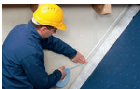
Vesikatteen aluskatteen yhdistäminen massi- iviseinärakenteeseen
