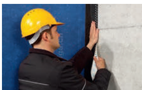
Julkisivun tuulensuoja- kankaan yhdistäminen massiiviseinärakenteeseen
