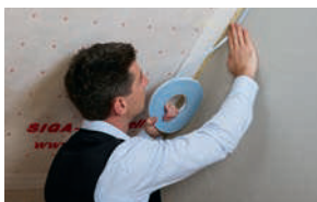
Höyrysulkukerroksen yhdistäminen massi- iviseinärakenteeseen
